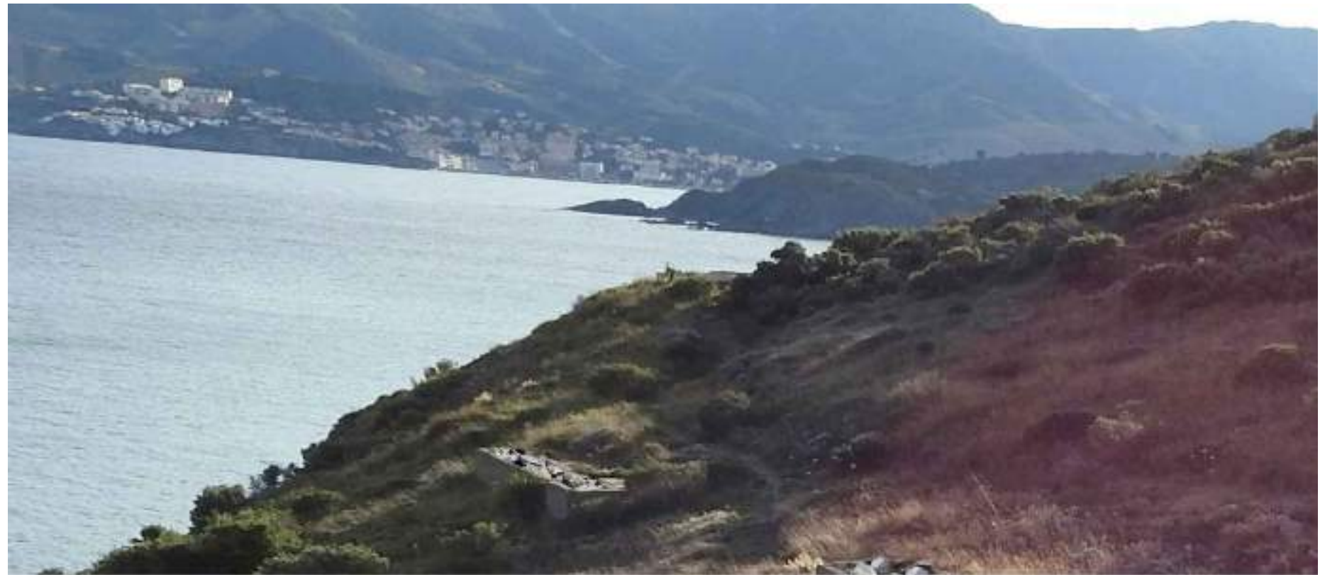
Action : Fermer l'ouvrage par le remblaiement de l'édifice avec des matériaux issus de la destruction des différents ouvrages du site (bâtiments, escalier ...) Objectif : Limiter les points de curiosité attractifs, sécuriser le site et favoriser la renaturation spontanée
