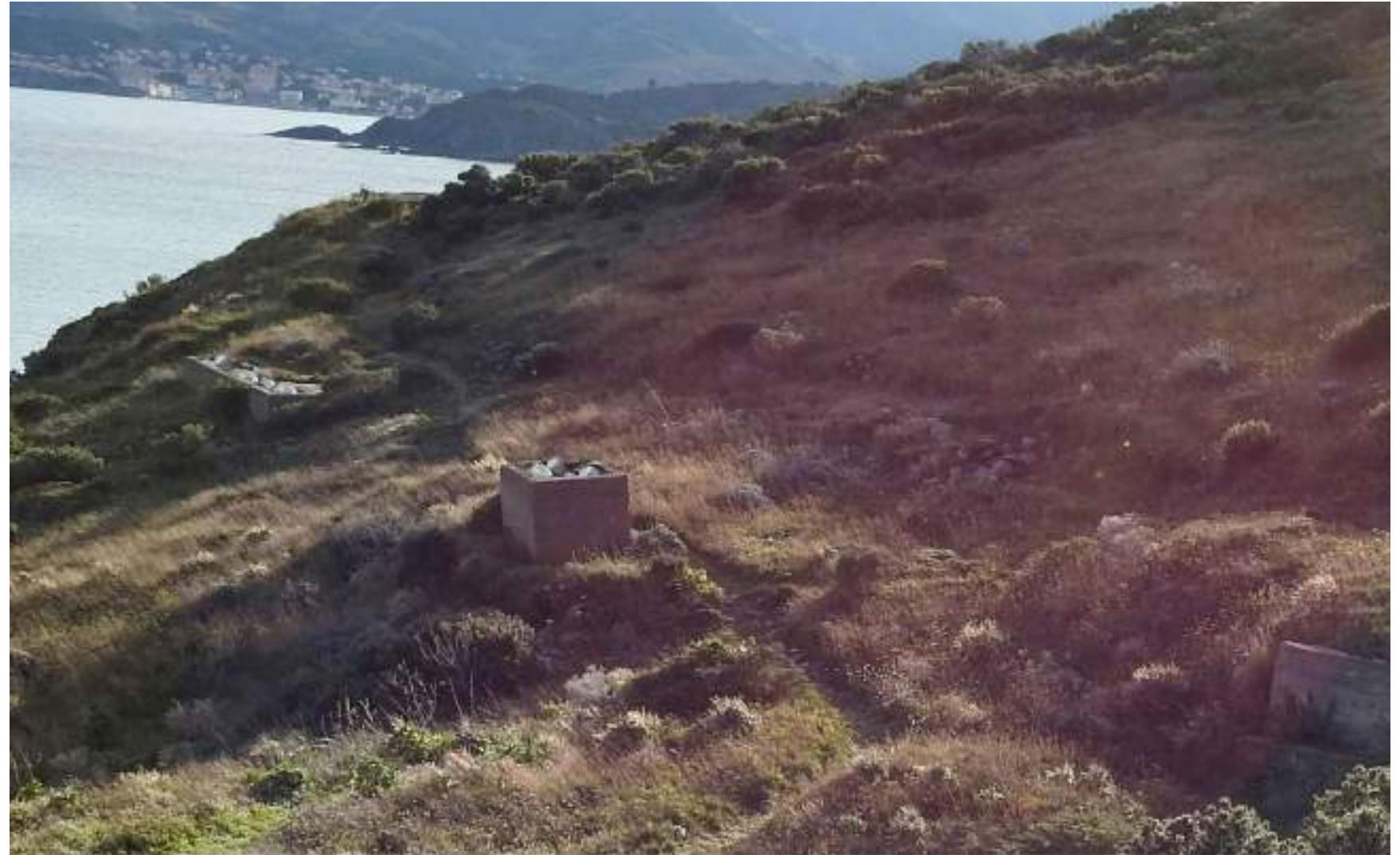
Action : Fermer l'ouvrage par le remblaiement de l'édifice avec des matériaux issus de la destruction des différents ouvrages du site (bâtiments, escalier ...) Objectif : Limiter les points de curiosité attractifs, sécuriser le site et favoriser la renaturation spontanée
