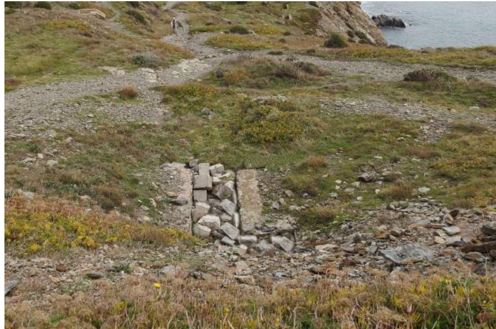
Action : Fermer l'ouvrage par des pierres présentent sur site Objectif : Limiter les points de curiosité attractifs et sécuriser le site
