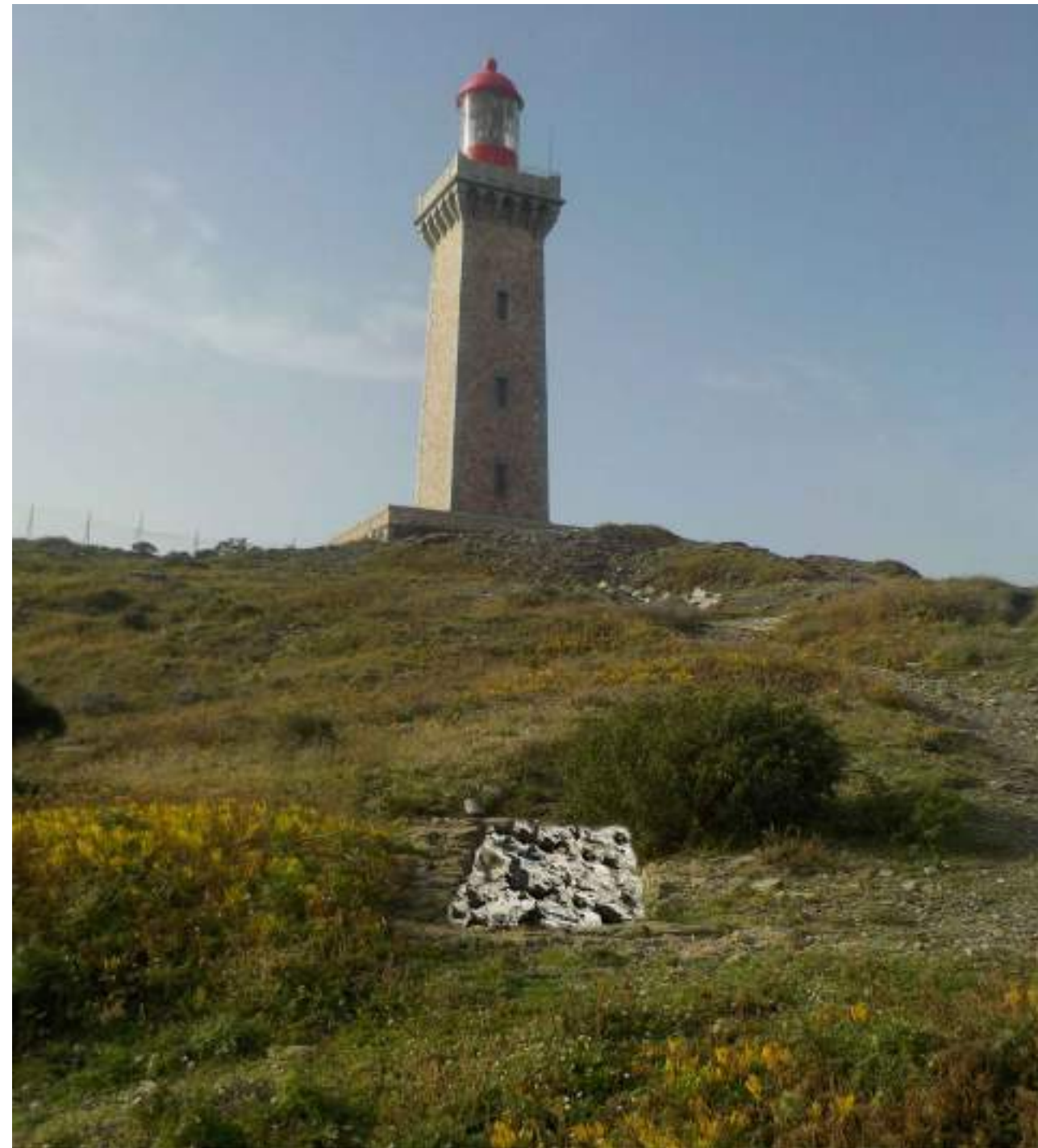
Action : Fermer l'ouvrage par le remblaiement de l'édifice avec des matériaux issus de la destruction des différents ouvrages du site (bâtiments, escalier ...) Objectif : Limiter les points de curiosité attractifs, sécuriser le site et favoriser la renaturation spontanée
