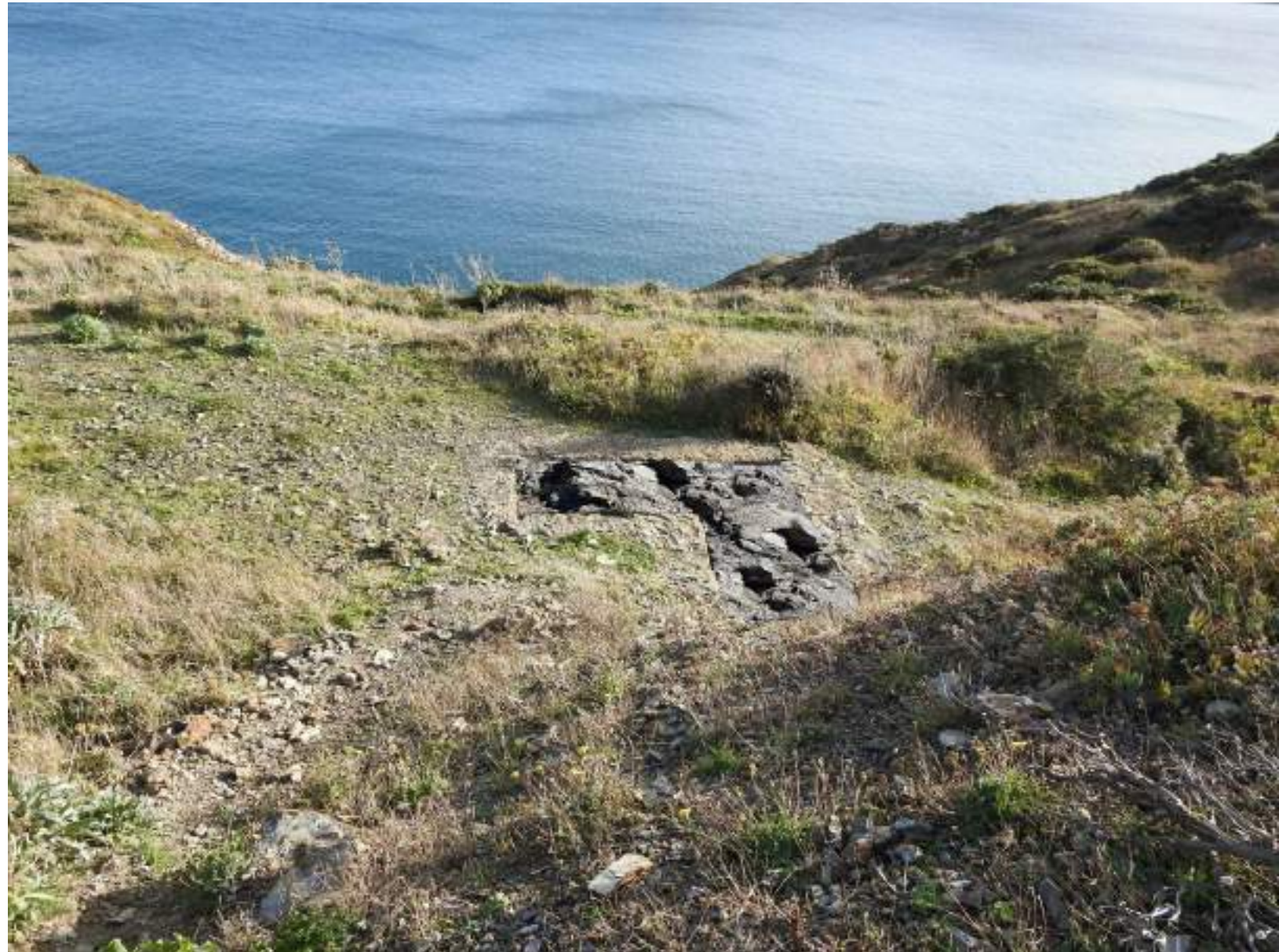
Action : Fermer l'ouvrage par le remblaiement de l'édifice avec des matériaux issus de la destruction des différents ouvrages du site (bâtiments, escalier ...) Objectif : Limiter les points de curiosité attractifs, sécuriser le site et favoriser la renaturation spontanée
