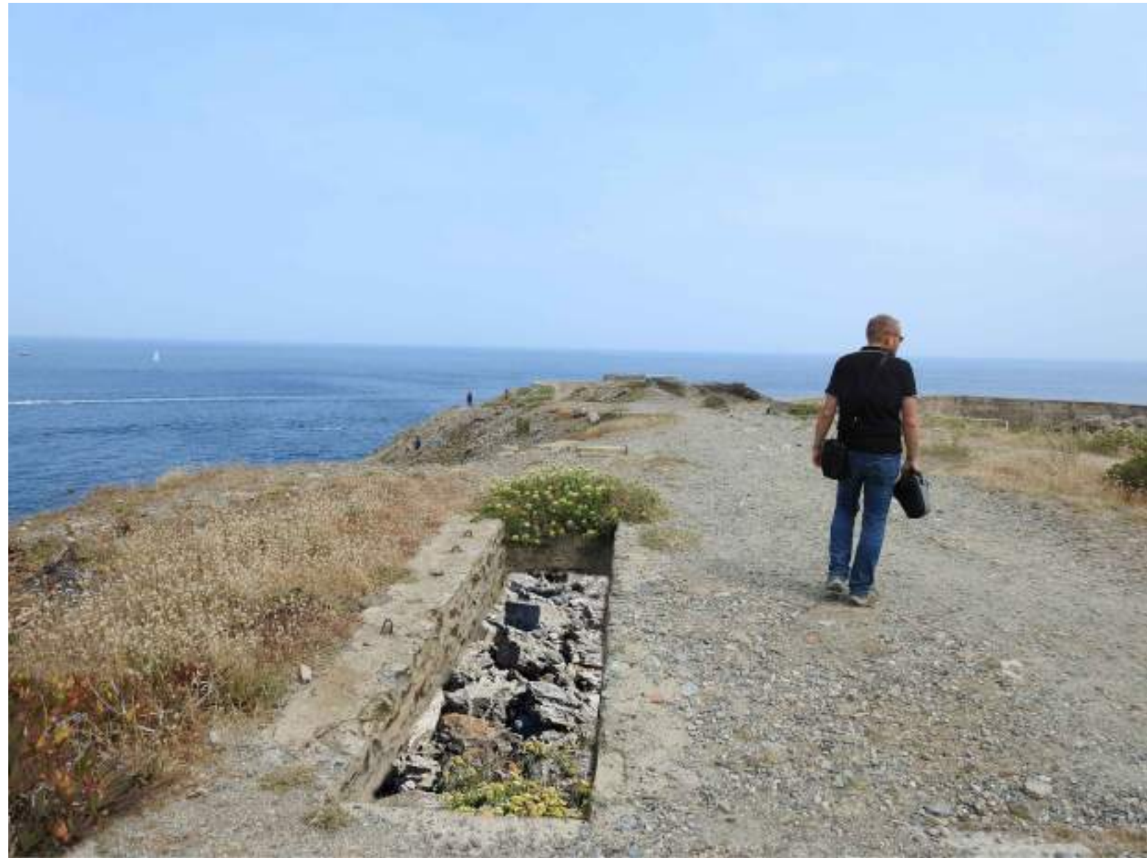
Action : Fermer l'ouvrage par le remblaiement de l'édifice (jusqu'à -40cm) avec des matériaux issus de la destruction des différents ouvrages du site (bâtiments, escalier ...) Objectif : Limiter les points de curiosité attractifs, sécuriser le site et favoriser la renaturation spontanée
